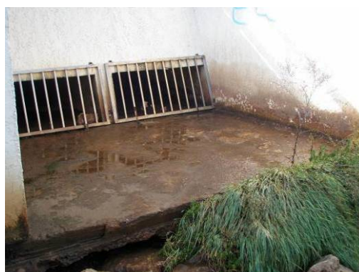
O2 - O3 - 10/2015 (exutoire pluvial)
