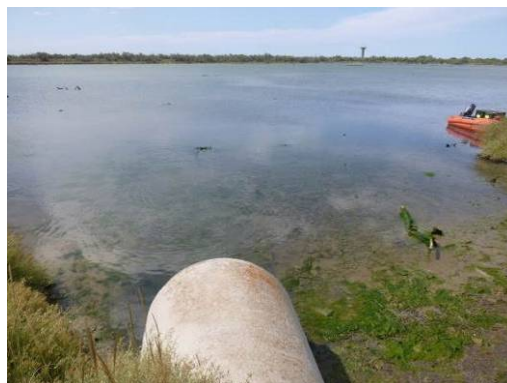
Débouché du fossé dans l'étang - N1 – 08/2015
