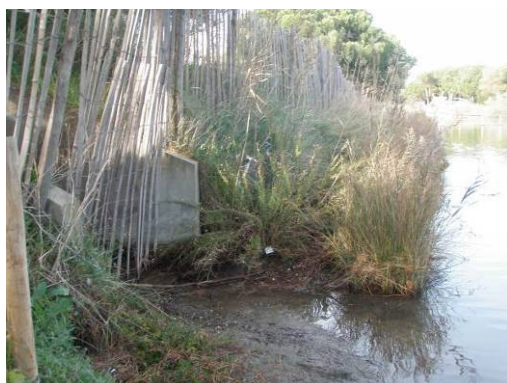
O4 - 10/2015 (exutoire pluvial)
