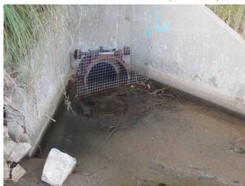
O5 - 10/2015 (exutoire pluvial)
